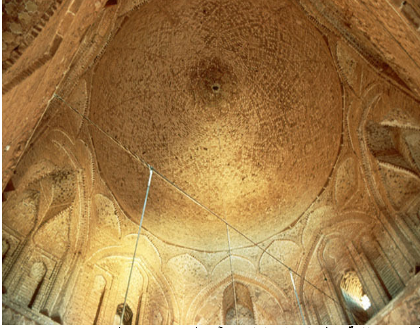
لوحة رقم ١٧. القبة وطريقه التسقيف بالأجر (مسجد زوره)
